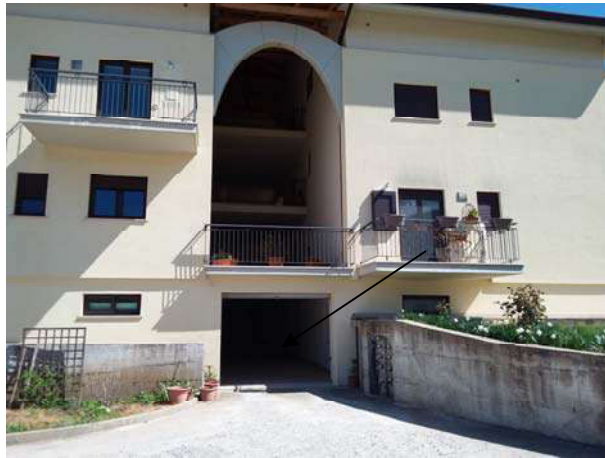
Foto 1 (ingresso comune garage)
